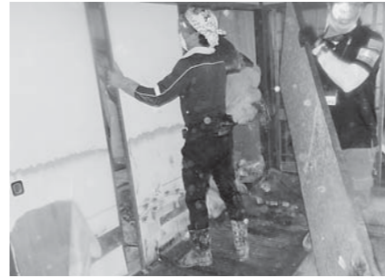
2階での作業。襖(ふすま)に浸水の跡が残っていました
