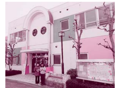
西山田児童センターは公園に隣接しており、センターの裏側からは公園の広場へ直接出入りできます
