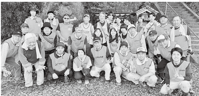
被災家屋、土砂搬出や 片づけ作業で大奮闘
